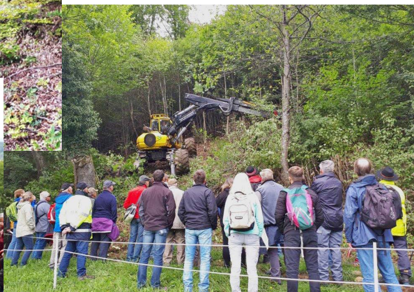
Um die nötigen Flächen zu erstellen sind auch grosse Maschinen im Einsatz.
